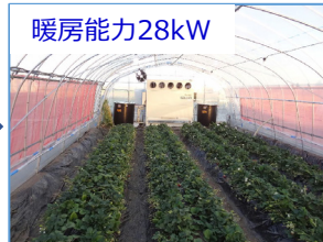
試作・開発中の施設園芸用ヒートポンプ (10馬力機) と改良 (農研機構)
